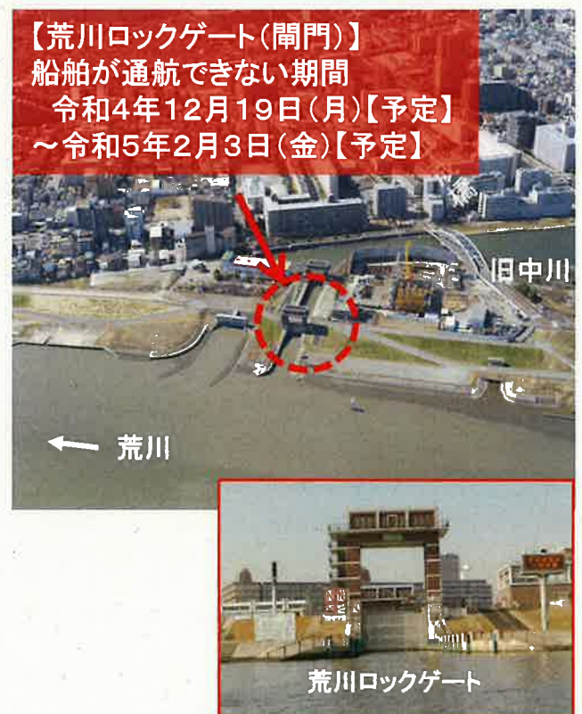
【荒川ロックゲート周辺写真】
